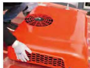
3. Установить накрывный блок
