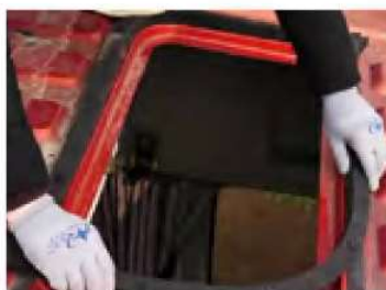
2. Прикрепить уплотнитель по контуру люка
