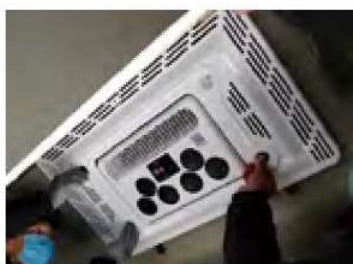
4. Закрепить кондиционер крепёжным швеллером, закрыть облицовочной рамкой
